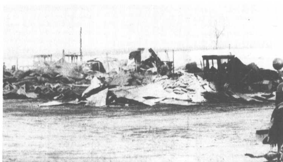
DES DOMMAGES ÉVALUÉS À $200,000 ont été le résultat d'un incendie la semaine dernière aux installations de la ville de Montréal dans la Côte de Terrebonne. (PHOTO LA REVUE)
