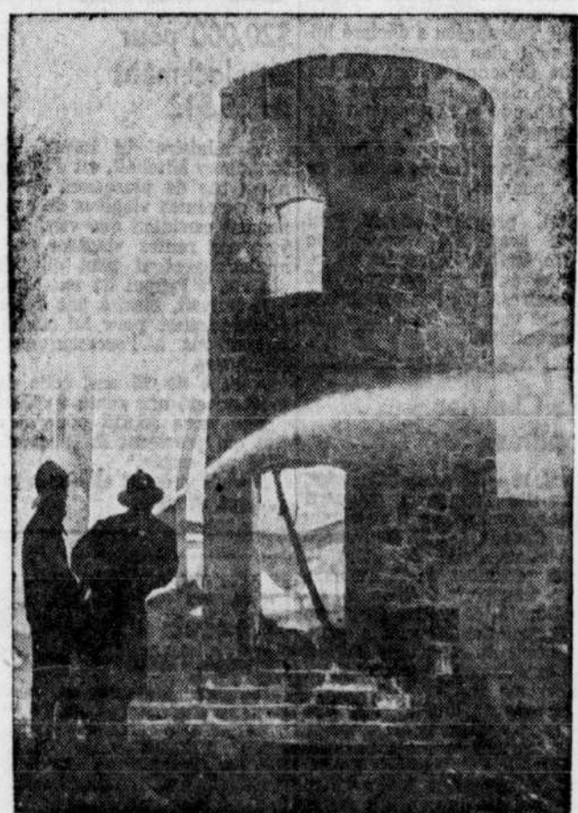
UN PERTE COMPLETE — Un incendie dont la cause aurait été un court-circuit a détruit l'hôtelier "La Belle Chaudière", à Val-David, samedi matin. Les pompiers de Sainte-Agathe et de Val-Morin, accourus sur les lieux, n'ont pu éteindre l'incendie, qui s'est répandu avec une prodigieuse rapidité. L'hôtel est complètement rasé.
