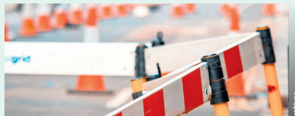
Les usagers de la route passant sur la route 339 à Saint-Roch-Ouest et Saint-Lin-Laurentides doivent s'attendre à des entraves dans les jours à venir en raison de travaux de réfection d'un ponceau.
