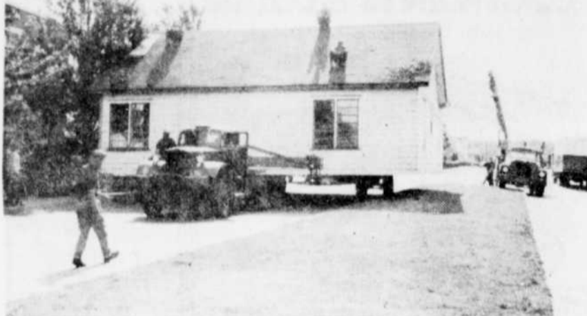
ON DEMENAGE. — Une équipe d'hommes de M. Normand Senay, ont procédé hier au déménagement d'une résidence qui était située à l'intersection des rues St-Hubert, St-André et boulevard Leclerc à Granby, où l'on doit ériger un poste d'essence. Elle a été conduite sur le chemin de Canahan, à l'extérieur de la ville. Une autre résidence située dans le même quadrilatère tombera prochainement sous le pic des démolisseurs puisqu'elle est trop âgée pour être démenagée.
