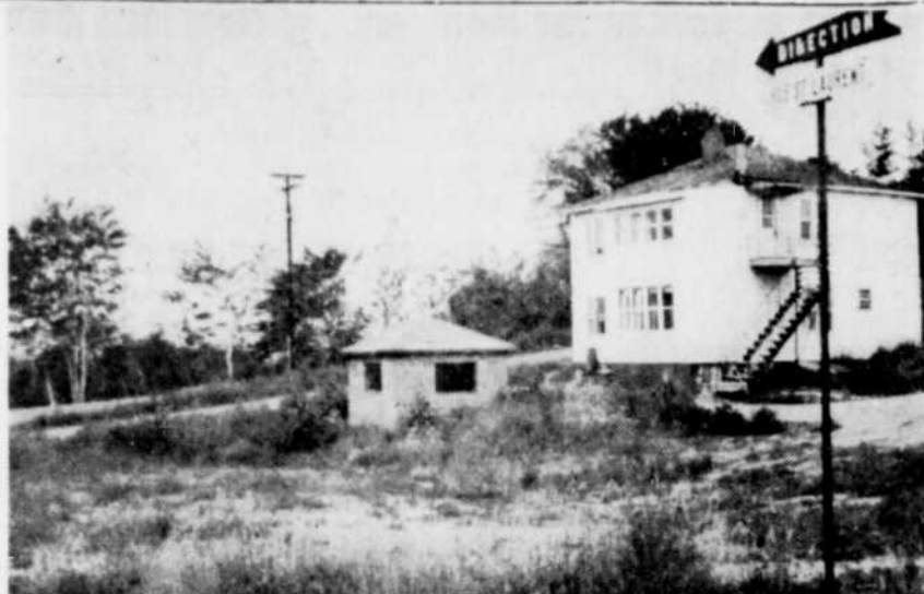
D'APPARENCE ANODINE, cette petite construction (à gauche) de simples blocs de pierre, aux fenêtres défoncées et à l'entourage de foin et de mauvaises herbes, pourrait bien être le refuge d'une grande partie de la population de Windsor qui se cherche de la bonne eau à boire. En effet, cette bâtisse abrite un puits artésien abandonné depuis quelque 15 ans. L'échevin Riendeau coresse le projet de la faire encore servir pour une somme de quelque centaines de dollars. Elle serait une solution efficace aux citoyens de la rue St-Jean en particulier, qui se plaignent que leur eau est souvent insalubre du fait qu'elle ne circule pas.
