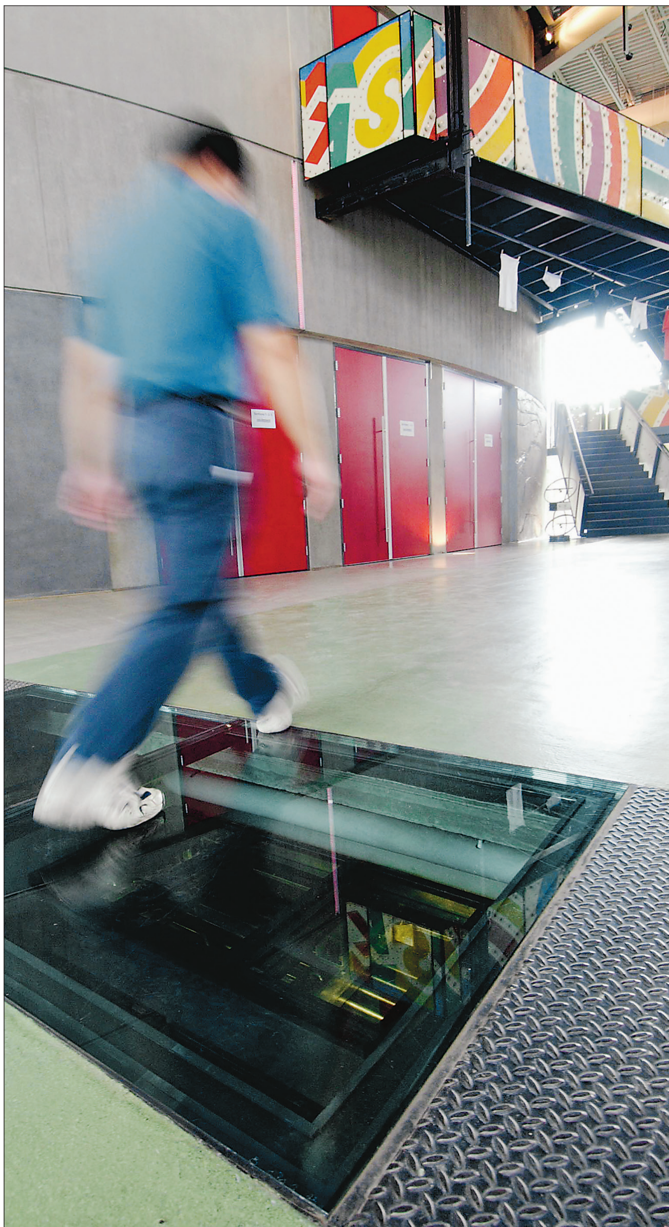
Les spectateurs qui se rendent dans la salle circulaire de la TOHU doivent marcher sur une vitre qui leur permet d'apercevoir l'énorme bac à glace qui climatise l'édifice. En gelant l'eau accumulée dans un grand réservoir, la TOHU peut ainsi diminuer de façon importante sa consommation d'électricité.
