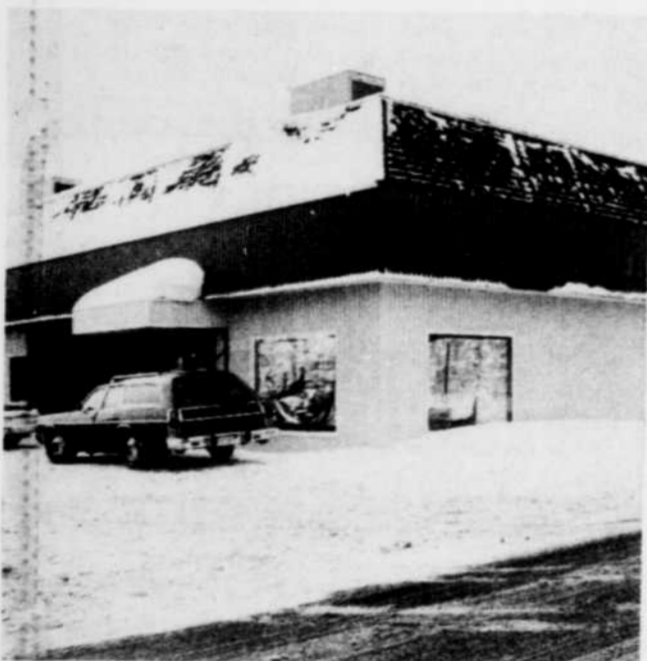
Le commerce se porte bien à Drummondville. A preuve, cet agrandissement impressionnant, rue St-Pierre, de la firme de matériaux de construction, Dionne et Fils.
