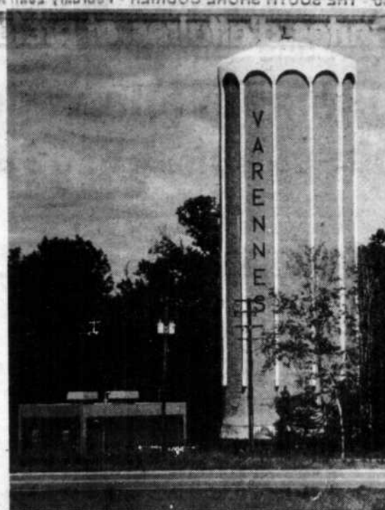
Varennes possède un réservoir de 500,000 gallons non loin de l'usine de filtration.
