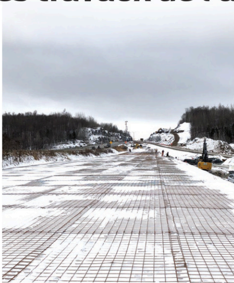
Un aperçu du chantier d'élargissement de l'autoroute 50 à la hauteur de la route 309
