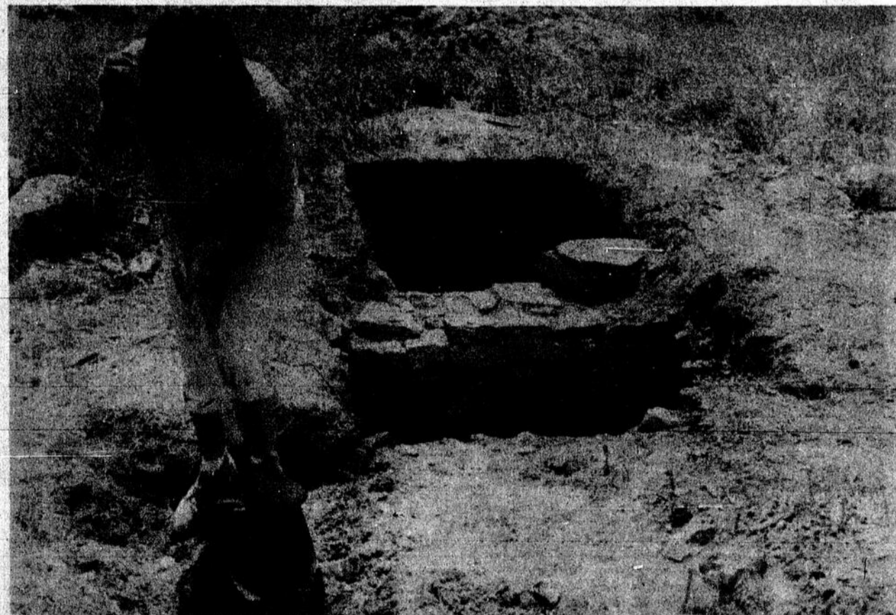
Nous apercevons dans la photo ci-dessus une jeune fille qui travaille d'arrache-pied (c'est le cas de le dire!) à découvrir les fondements de l'ancien hôpital. Nous voyons une partie des fondements au centre de la photo.
