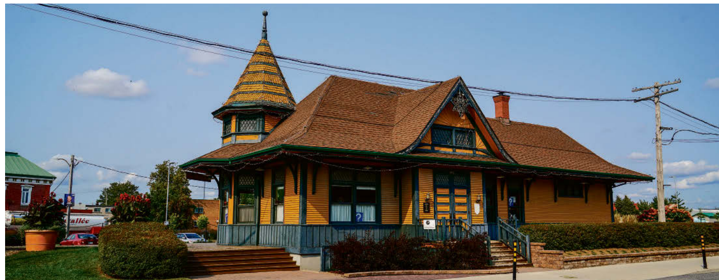
Bâtiment emblématique à Acton Vale, la gare est aussi devenue le port d'attache de la Chambre de commerce et de Joanne Joannette.
