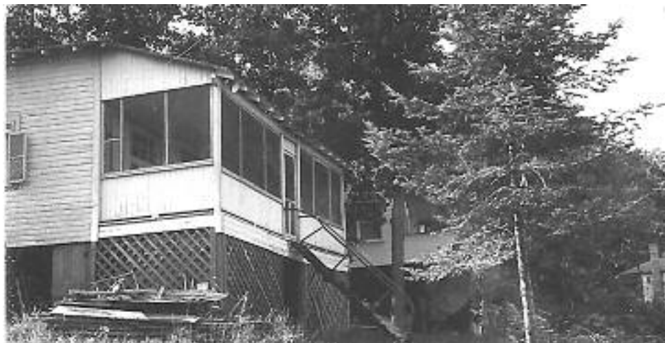
Chalet en construction d'Aimé Pilon, 715, rue du Cap, Lac Connelly Sud
