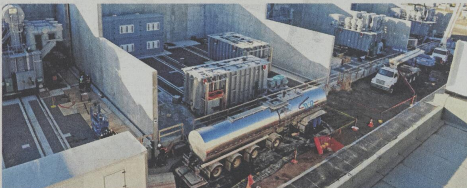
Usine pilote AP50 - Investissement en 2009 de près de 150 millions $
