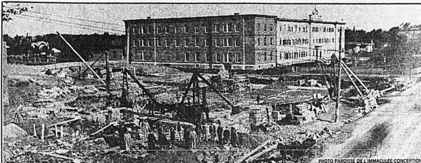
Les débuts de la construction de l'église en 1895. À l'arrière plan, le scolasticat avec son aile Papineau.
