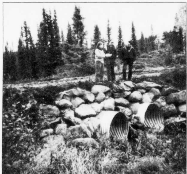
TRAVAUX - Du côté de la foresterie, plusieurs ZEC ont fait appel à l'ingénieure forestière du RRGZ afin de restaurer ou de remplacer certains ponceaux. Ces travaux sont indispensables afin de préserver la viabilité de la ressource faunique aquatique tel l'omble de fontaine et aussi pour assurer l'accessibilité au territoire.
