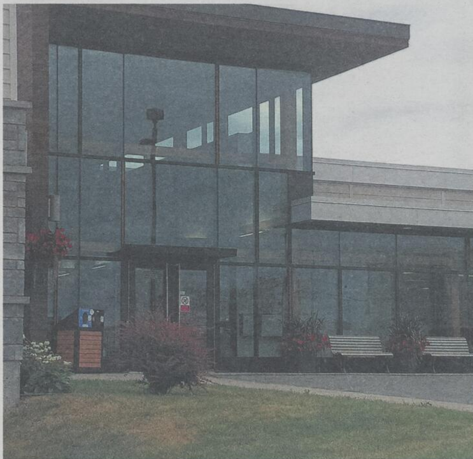
Vue d'une partie du Centre multifonctionnel. (Photo TC Media)
