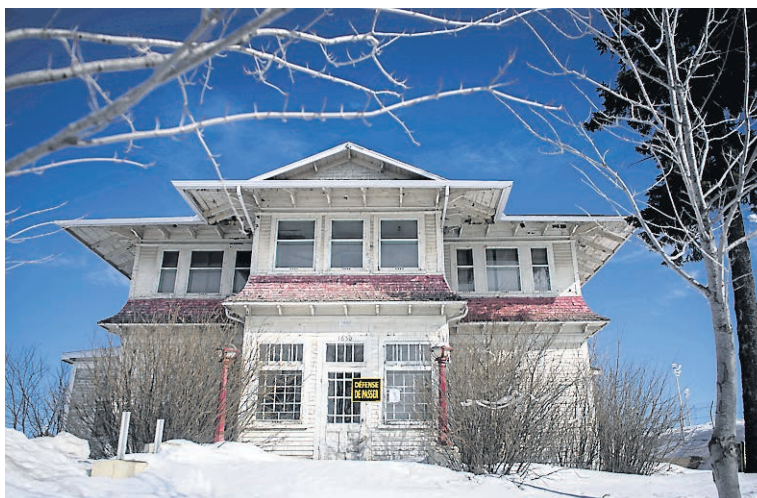
La Maison de l'Expo, déjà placardée et laissée à l'abandon, sera démolie. — PHOTO: FRANÇOIS GERVAIS
