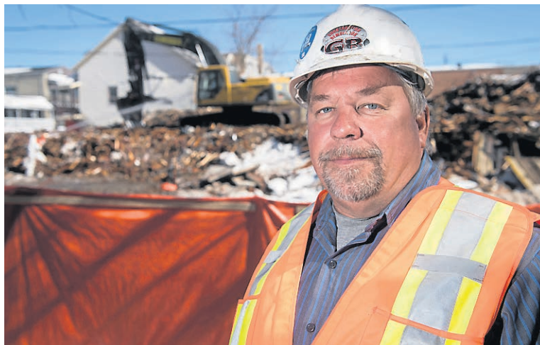
Guy Boisvert, propriétaire de Construction et démolition GB, devant le chantier de démolition de l'hôtel de La Salle, mardi matin. — PHOTO: FRANÇOIS GERVAIS.
