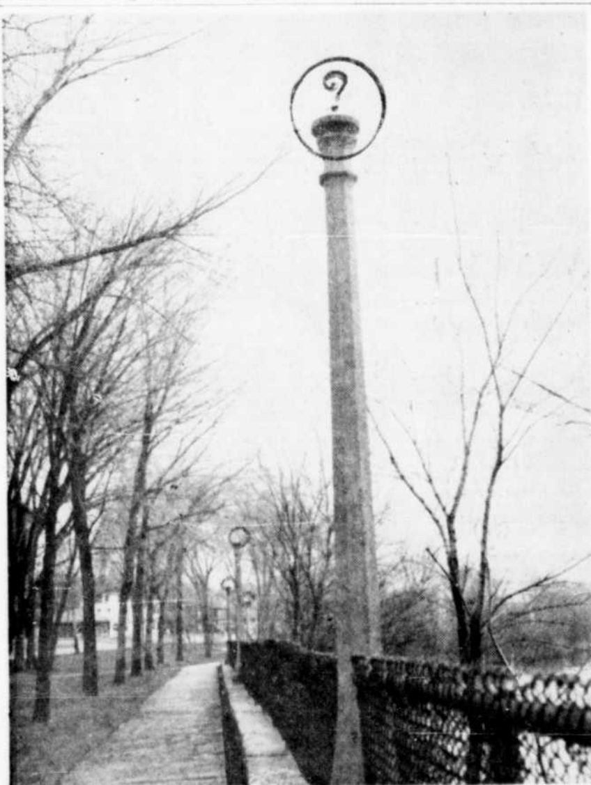
S'agit-il d'obélisques...? — Ce lampadaire a perdu sa tête... il n'est pas le seul, puisque six autres de ses semblables sont dans le même cas sur le boulevard St-François nord, près de la rivière. Les globes et les ampoules de sept lampadaires ont été brisés. S'agit-il de vandales, d'enfants, de mauvais plaisants ou autres? On l'ignore, mais la farce n'est pas tellement drôle!
