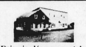
Epicerie dépanneur et logements, Route 138, Franquelin.
