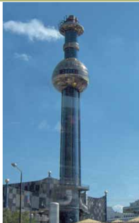
Incinérateur de Vienne en Autriche en fonction depuis 1992 assure le chauffage à l'eau.
