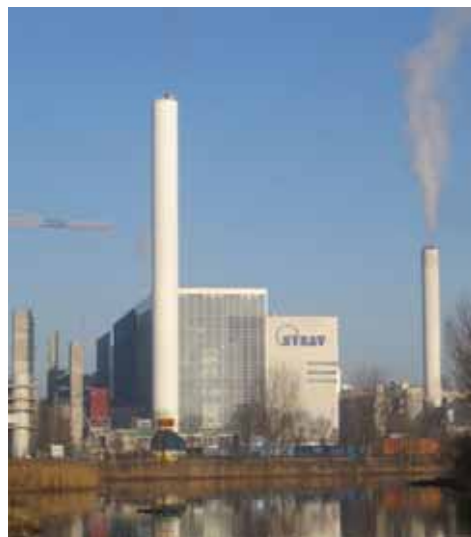
Incinérateur Malmö en Suède
