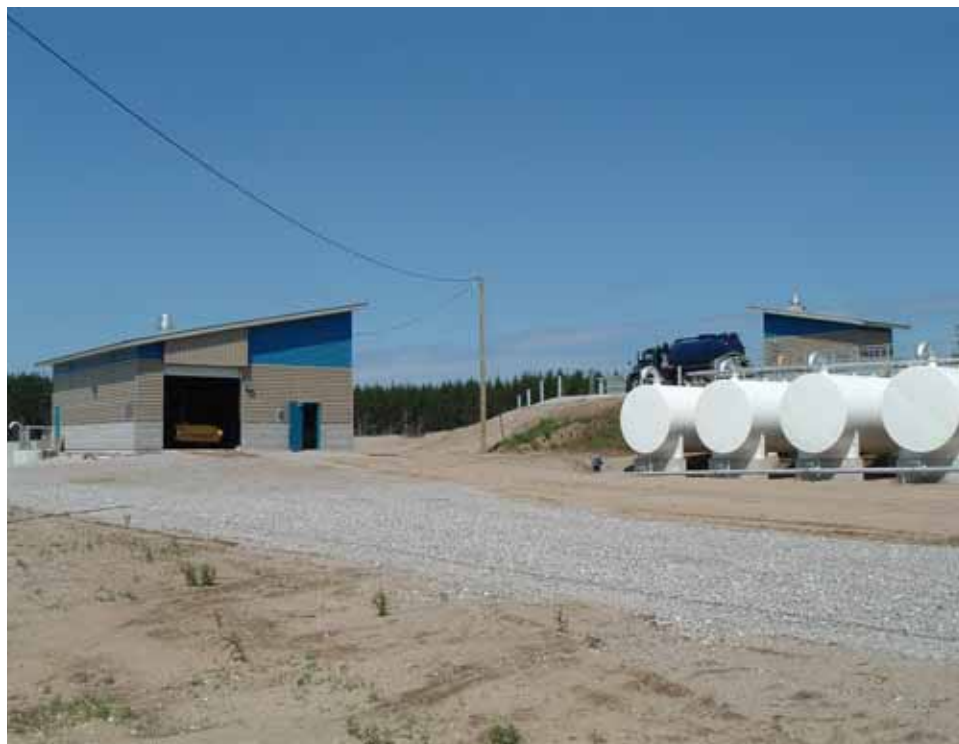
Installations pour le traitement des boues de fosses septiques à Kazabazua, dans la MRC de la Vallée-de-la-Gatineau
