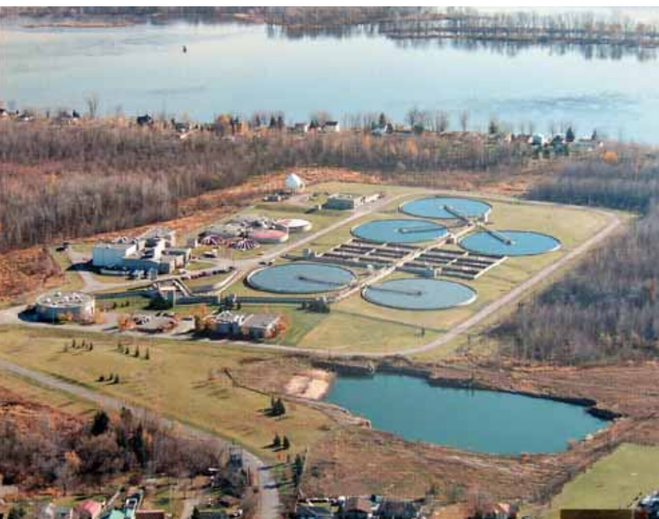
Bassins d'épuration des eaux usées de la ville de Gatineau
