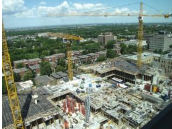
Le pavillon K en construction en 2012.
