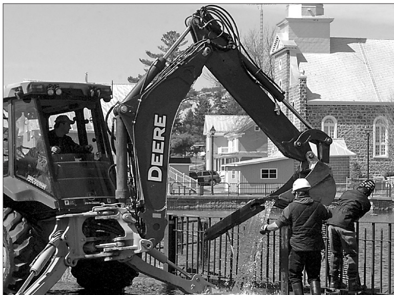
Les employés des travaux publics dégageaient des morceaux de bois emportés par le courant et coincés sous le pont.
