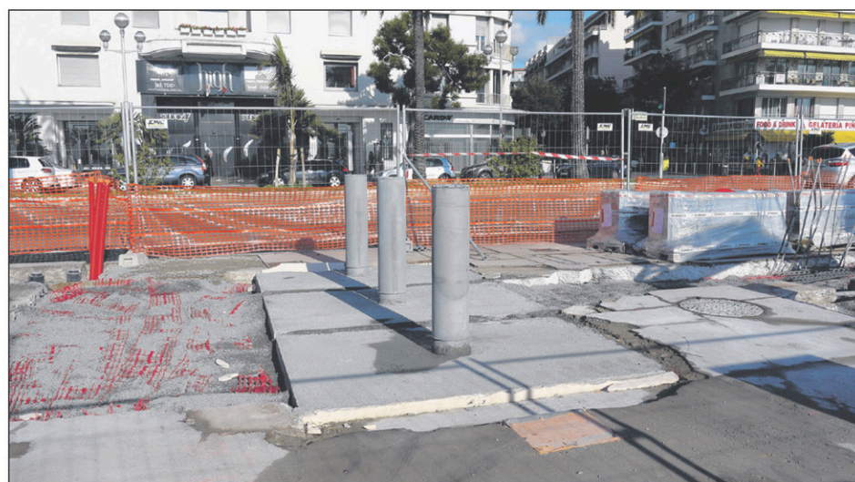
Depuis l'attentat du 14 juillet 2016, d'importants travaux sont en cours pour interdire l'accès aux véhicules sur une partie de la Promenade des Anglais.
