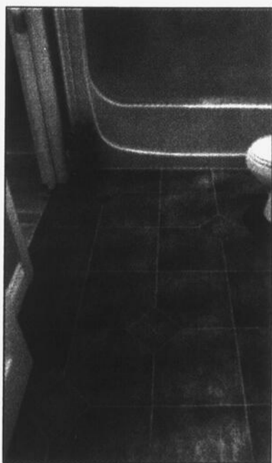
Installé sous les tuiles de céramique, le système de chauffage de plancher dégage une douce chaleur pour les pieds.
