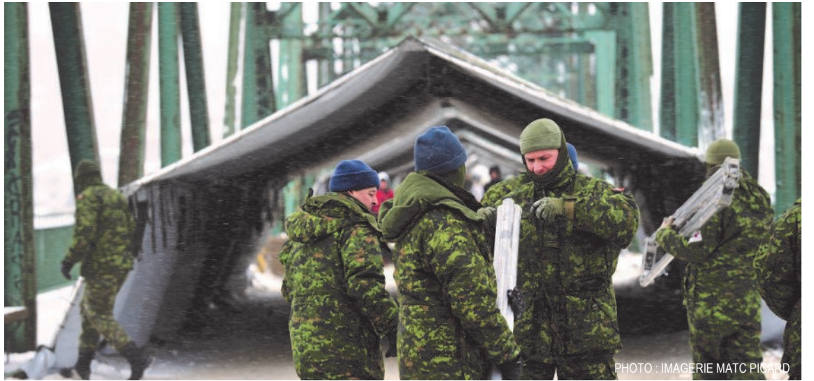
Une centaine de militaires de Bagotville ont collaboré à l'installation de plus 95 tentes, pour protéger les marcheurs sur le pont Sainte-Anne, à la suite de la fermeture du pont Dubuc à la circulation.
