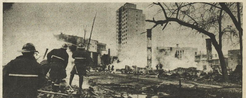
De vieux immeubles non entretenus qui sont d'un bon rapport pour les propriétaires. Mais lorsque le feu prend, ce sont les locataires qui sont dans la rue... (photo Michel Giroux)
