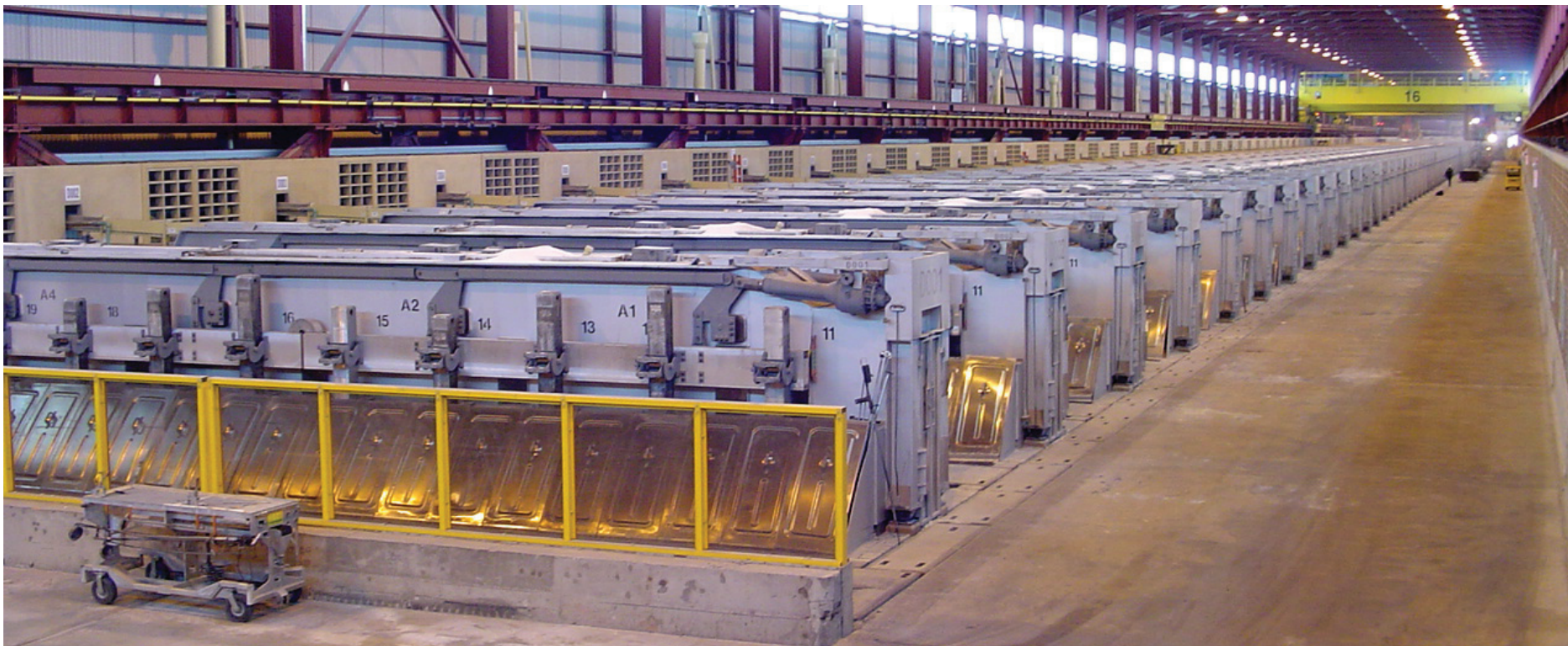
Des dizaines de cuves sont alignées dans un des halls d'électrolyse d'Aluminerie Alouette.
