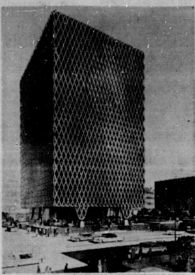
NOUVELLE CONCEPTION ARCHITECTURALE — L'immeuble IBM au centre de Pittsburgh, dans l'Ohio, sera le premier édifice au monde possédant une structure "d'intérieur" sur l'extérieur. Cette structure en acier sera couverte de triangles de verre clair et opaque, donnant à l'ensemble l'illusion d'un immense diamant.
