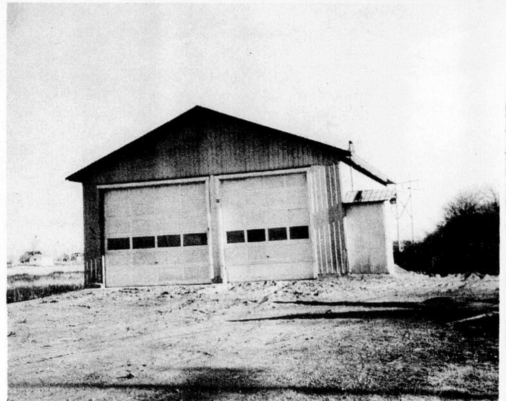
Comme par le passé, le garage municipal de St-Vallier paroisse servira surtout au remisage de l'équipement municipal, en particulier la machinerie qui est destinée à l'entretien des chemins d'hiver.
