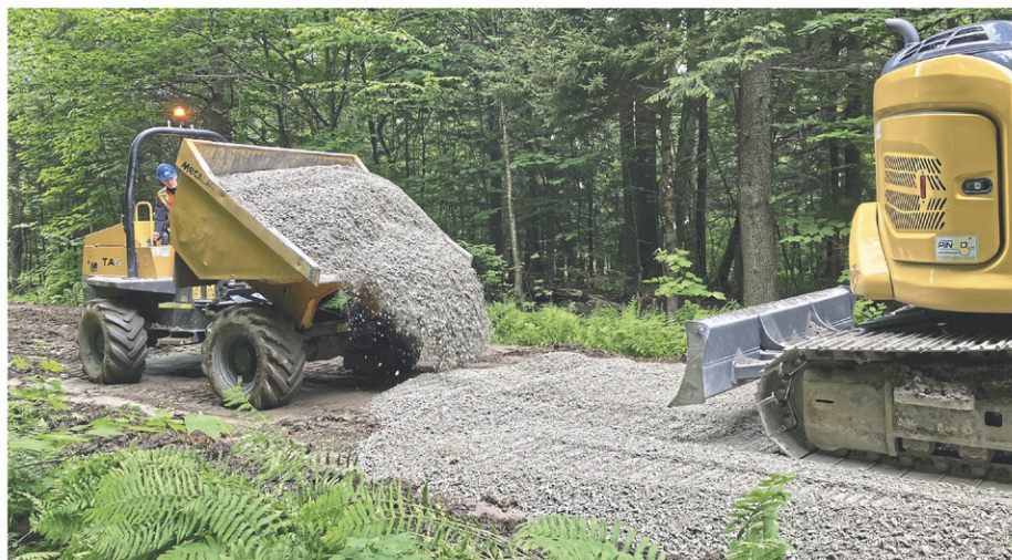
Des travaux de 1,4 million de dollars optimiseront le drainage des pistes, ce qui permettra de maintenir l'enneigement au sol plus aisément. (Photo gracieuseté)
