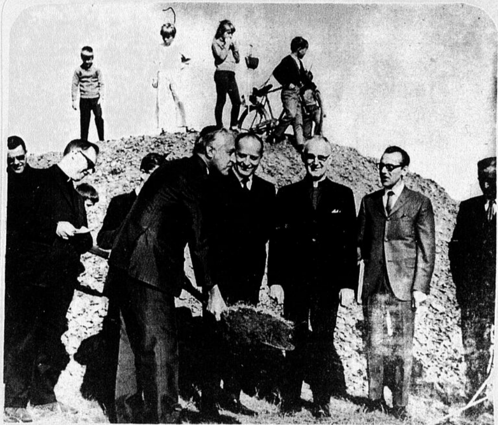
LA PELLETEE DE TERRE SYMBOLIQUE - L'Hon. Jean-Paul Cloutier a donné le feu vert pour le début des travaux du Centre de la Normandie en levant la première pellette de terre dimanche dernier, devant plusieurs centaines de personnes pour la plupart de la Normandie. Le ministre en a profité pour remettre à la Corporation, un chèque de $15,000., couvrant la moitié du projet. On reconnaît sur la photo, M. le curé Maurice Langlais, le maire Cajetan Gauthier, Mgr Paul-Emile Deschênes, M. Claude Hamelin et M. Marius Joncas.
