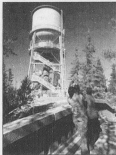
RUINES - Le secteur Les Ruines, qui constitue la première étape du Parcours des Bâisseurs, est un ancien réservoir d'eau potable construit à même le roc dans les années 20.
