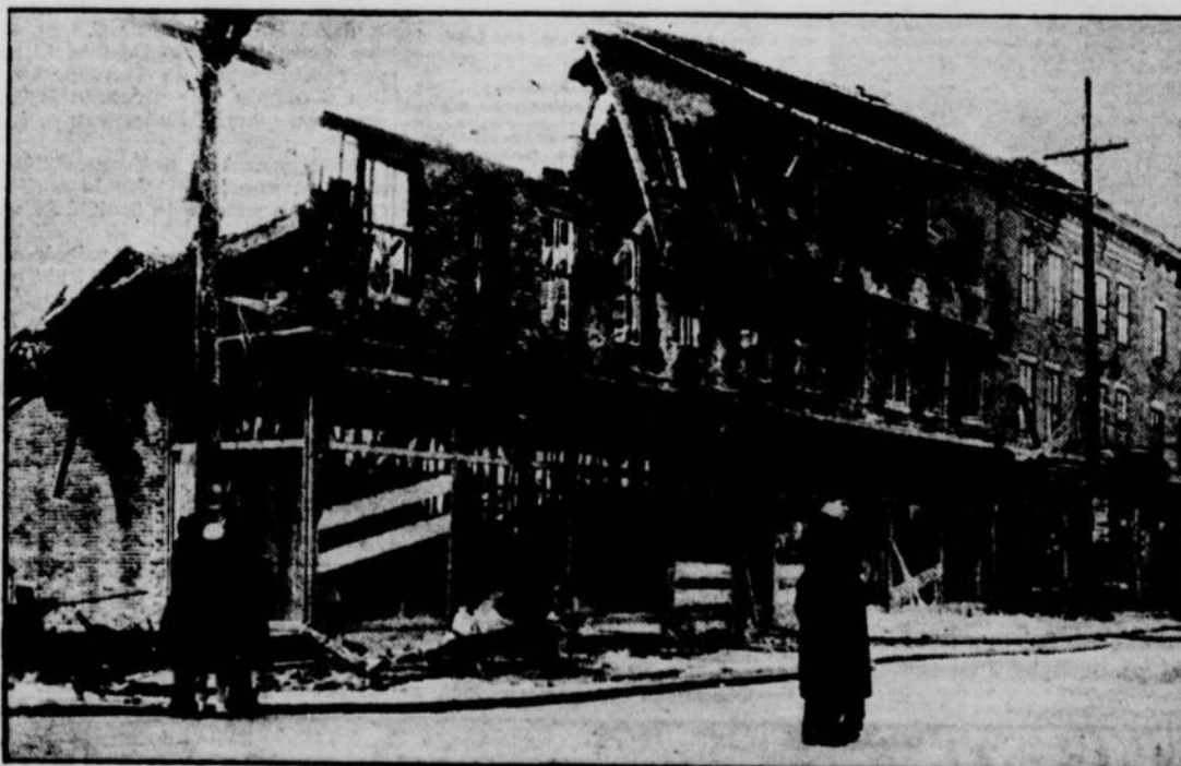
Des pertes évaluées à plus de $300.000 furent causées par un violent incendie à Saint-Jean. L'immeuble Langlois fut entièrement détruit par les flammes. (Photo la "Patrie").
