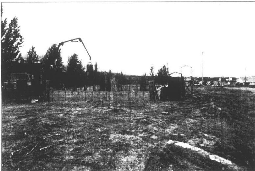
Les Jardins de l'Horizon en construction sur Laval-Nord. (Photo L'Écho)
