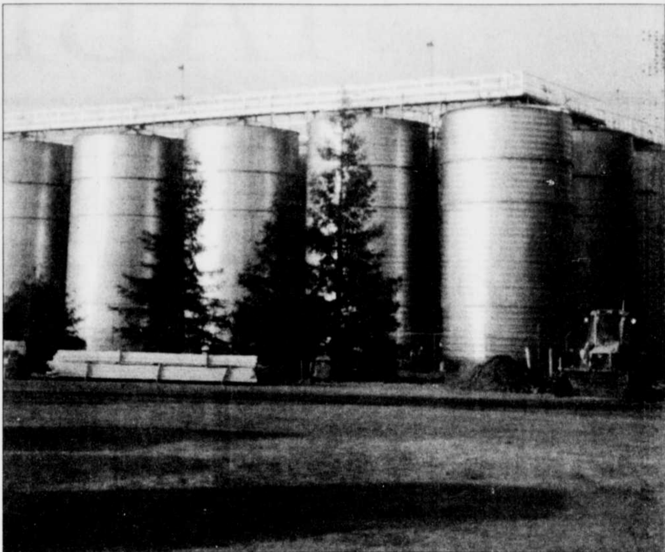
Les nouvelles usines de Gallo possèdent leurs propres centrales climatiques, au nombre de 22, évaluant l'humidité et le vent. Toutes ces informations sont reliées à un ordinateur central.
