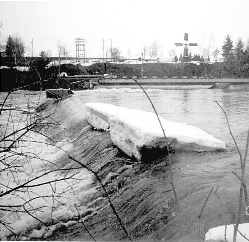
Les systèmes automatiques de contrôle des crues du barrage de Sainte-Brigitte-des-Saults ont été inopérants en avril 2001 quand les glaces de la rivière Nicolet se sont rompues et ont complètement obstrué le passage, provoquant la pire des nombreuses inondations survenues depuis 1993 en amont du barrage de la société en commandite Algonquin Power.
