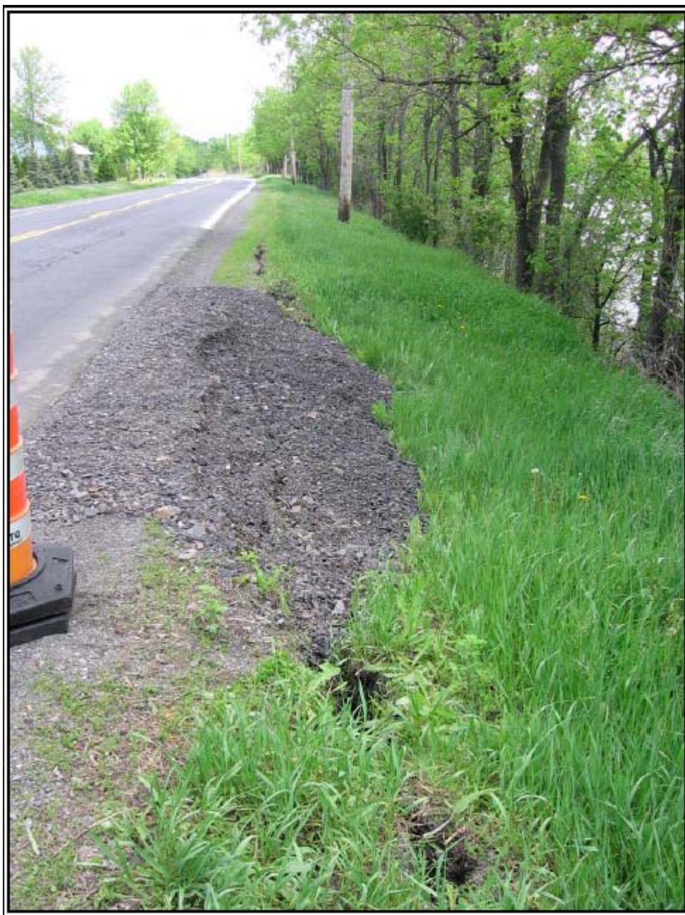
Photo 4 : Vue rapprochée vers l'aval du décrochement au site #3 (Saint-Marc-sur-Richelieu)
