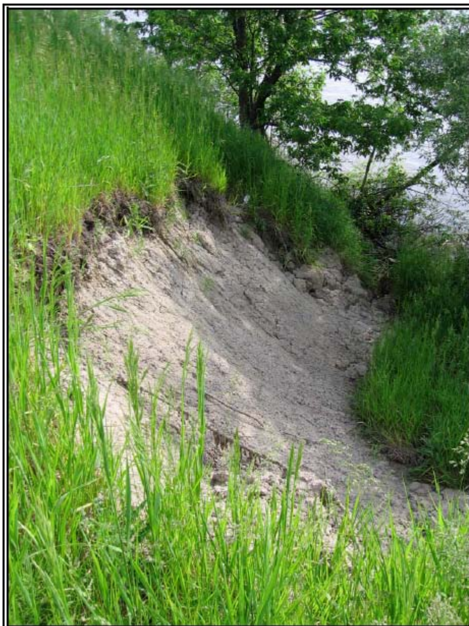
Photo 5 : Vue rapprochée vers l'aval du glissement au site #4 (Saint-Antoine-sur-Richelieu)
