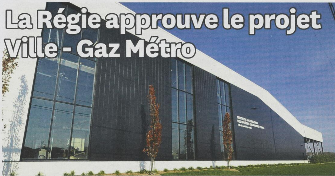
Le nouveau Centre de valorisation des matières organiques (CVMO), de l'avenue Émilien-Letarte, l'une des composantes du système de biométhanisation qui a été mis en place à partir de la station d'épuration de la rue Girouard Est. Photo François Larivière | Le Courrier ©
