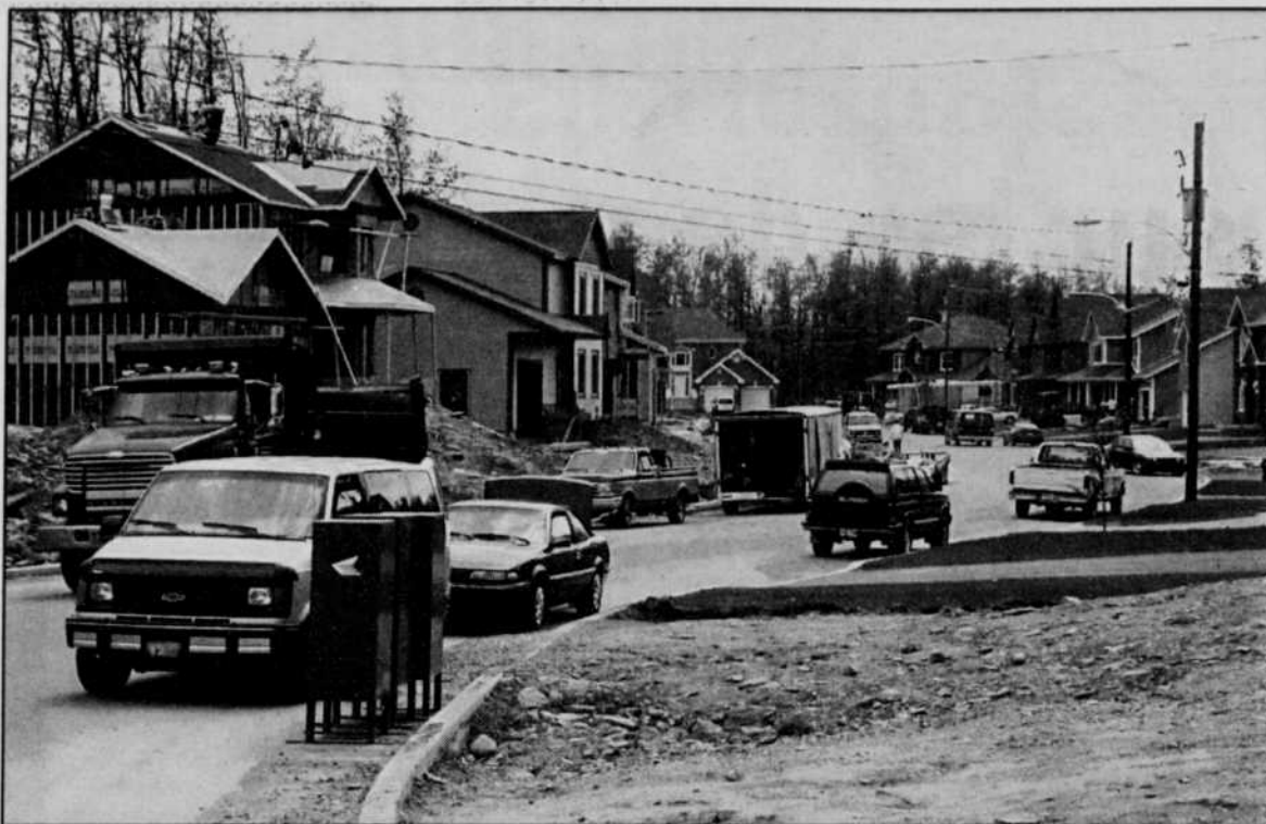
Une station de surpression de 110 000 $ devra être installée rue Dubé pour régulariser la pression de l'aqueduc dans ce secteur en développement.
