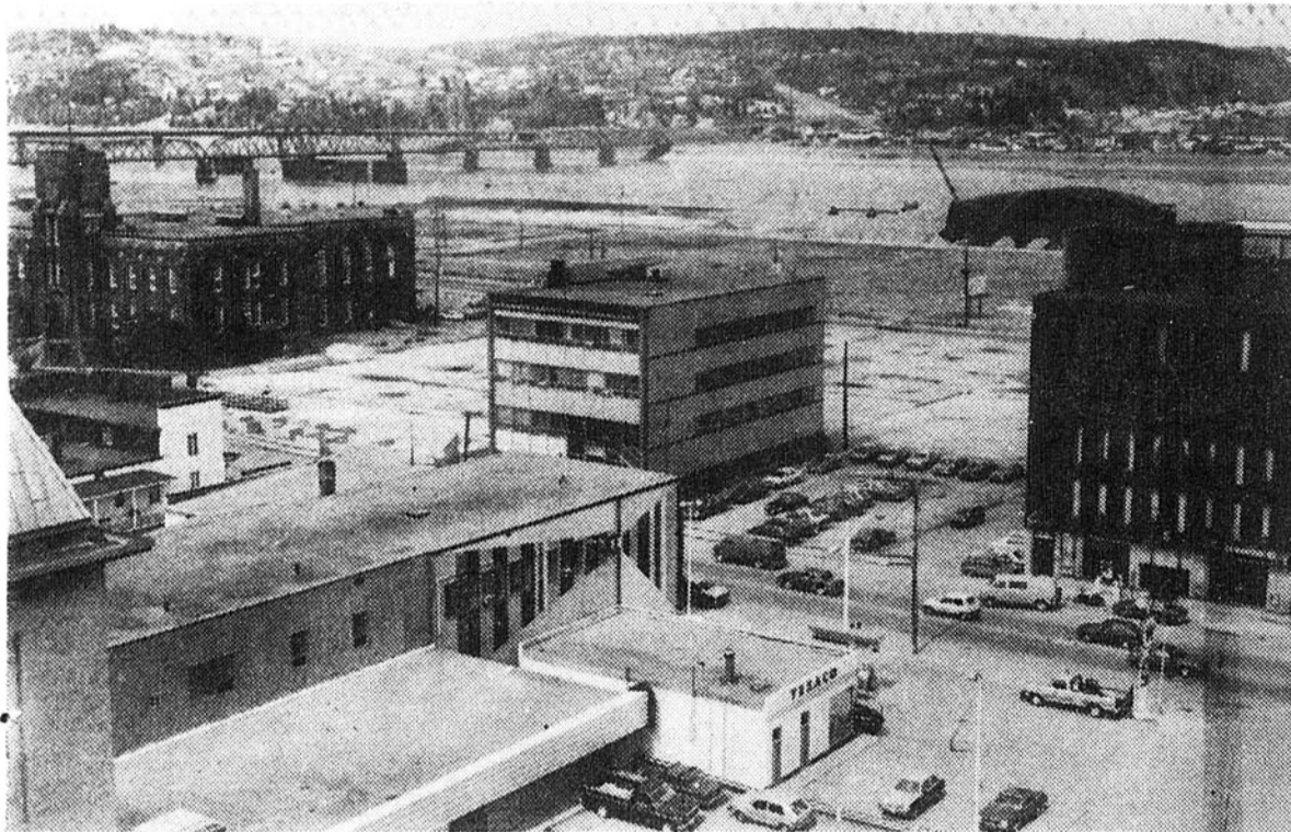
SECTEUR IMPORTANT — La section entre Lafontaine et Hôtel-de-Ville, de la rue Racine sera la première touchée. Arbres, bancs, lampadaires et poubelles ainsi que le granit et la
