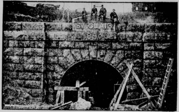
ENTRÉE DU TUNNEL
