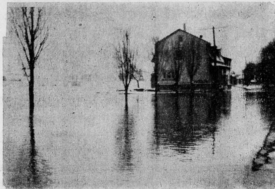
Inondation de 1947. La maison de M. Edmond Nolin.
