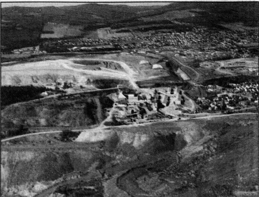
Dans un communiqué émis en fin d'après-midi hier, Lab Chrysotile évoque les conditions actuelles du marché pour expliquer la fermeture temporaire de la mine Bell, à Thetford Mines.
