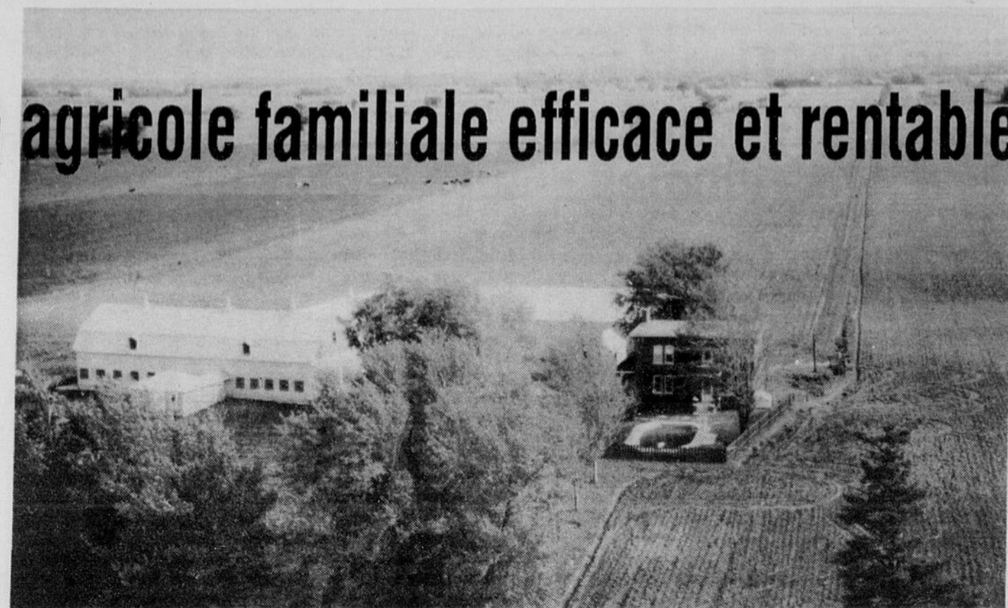
Vue d'ensemble de la Ferme R.F. Brière inc., on remarque que la maison, les bâtiments et les champs sont soumis à un bon programme d'entretien.
