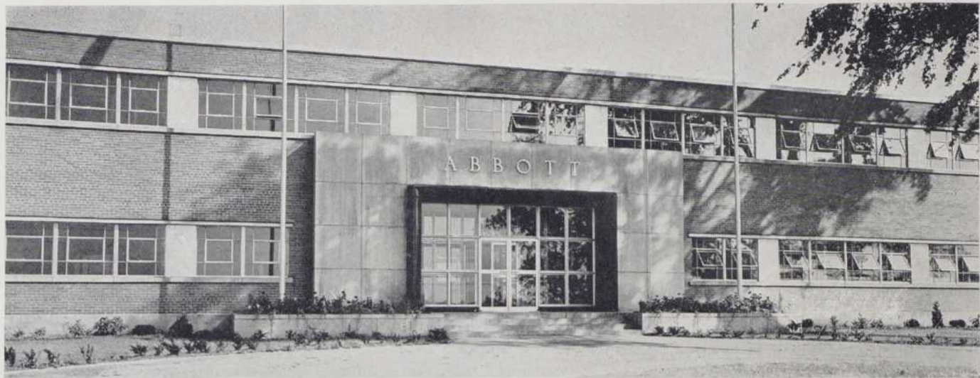
Détail de l'entrée aux Laboratoires Abbott. Le thème air et lumière joue à plein.
