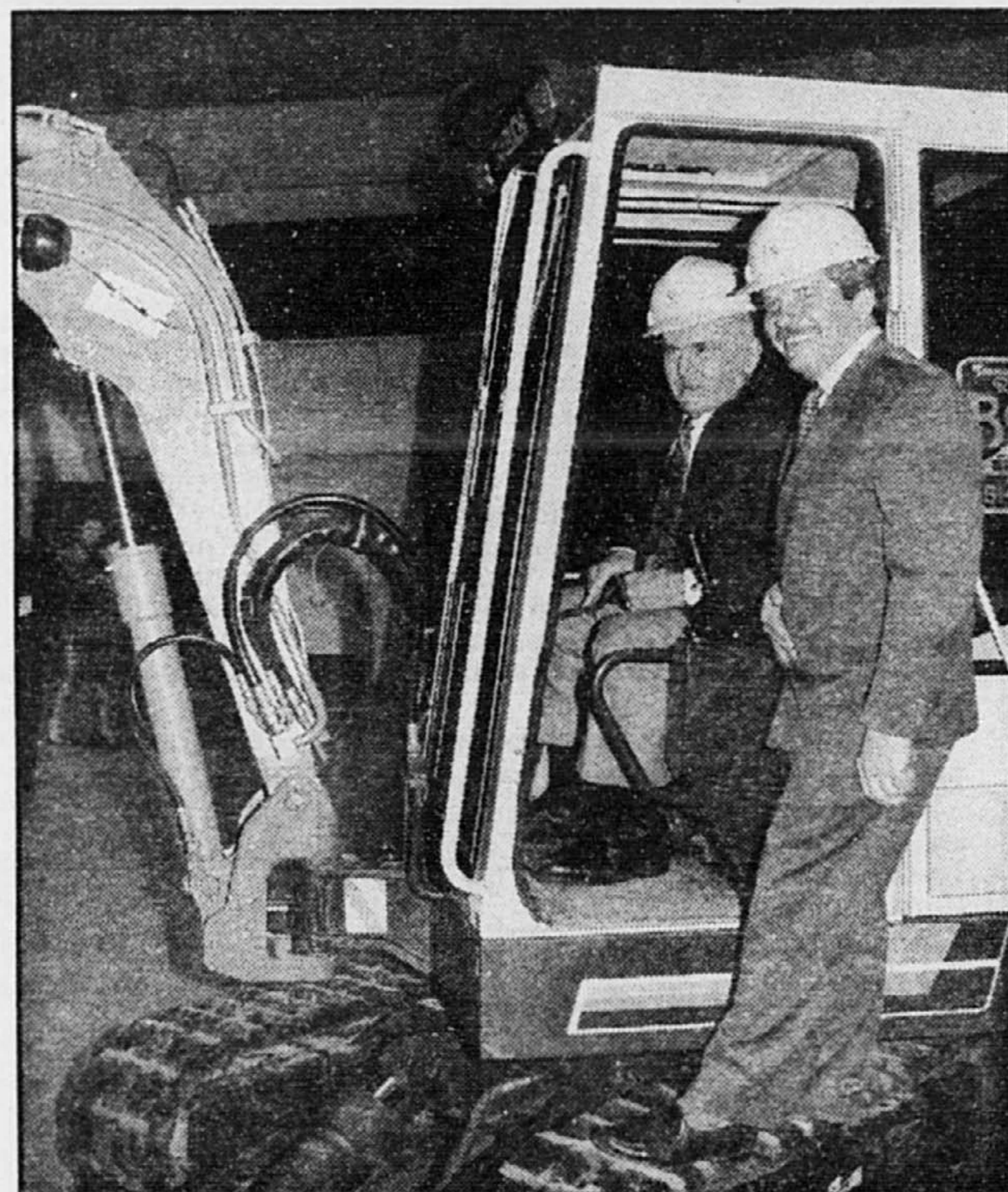
Maurice Richard était aux commandes d'une machine-outil dotée d'un marteau-piqueur, hier midi, et le maire Jean Doré l'assistait pour percer, les premiers, la dalle de ciment de la patinoire, qui doit être agrandie.
