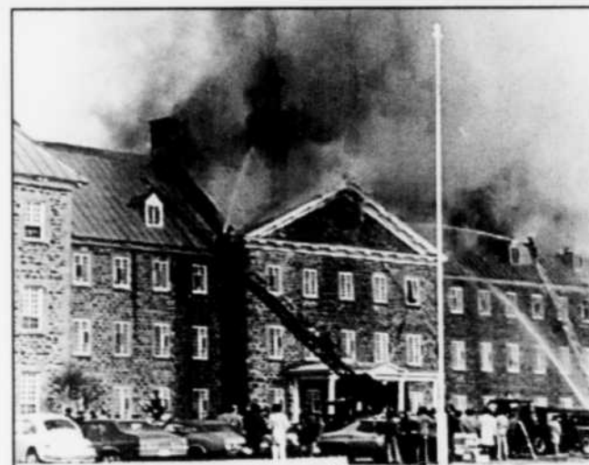
En 1973, un important incendie a détruit deux ailes du bâtiment historique, privant l'institution de 20 % de sa superficie totale.
