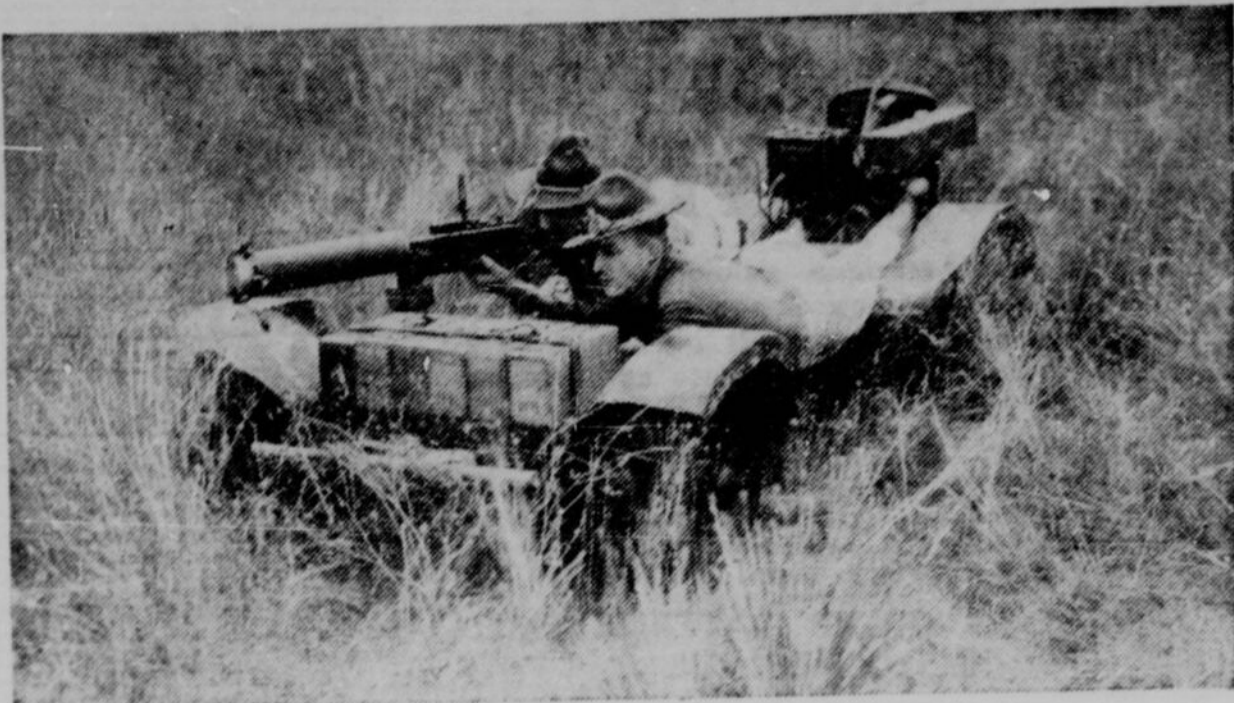
DERNIERE INVENTION MILITAIRE — Le nouveau char inventé et amélioré par le capitaine Robert G. Howie et le sergent M. C. Wiley de l'école d'infanterie américaine avance sur un terrain accidenté avec autant de facilité qu'un tank. Il permet le transport des mitrailleuses sans devoir en faire le démontage. La mitrailleuse est donc toujours prête à fonctionner, même pendant qu'on la transporte. Un pare-chocs placé à l'avant nettoie le chemin en brisant les buissons et l'herbe des prairies.
