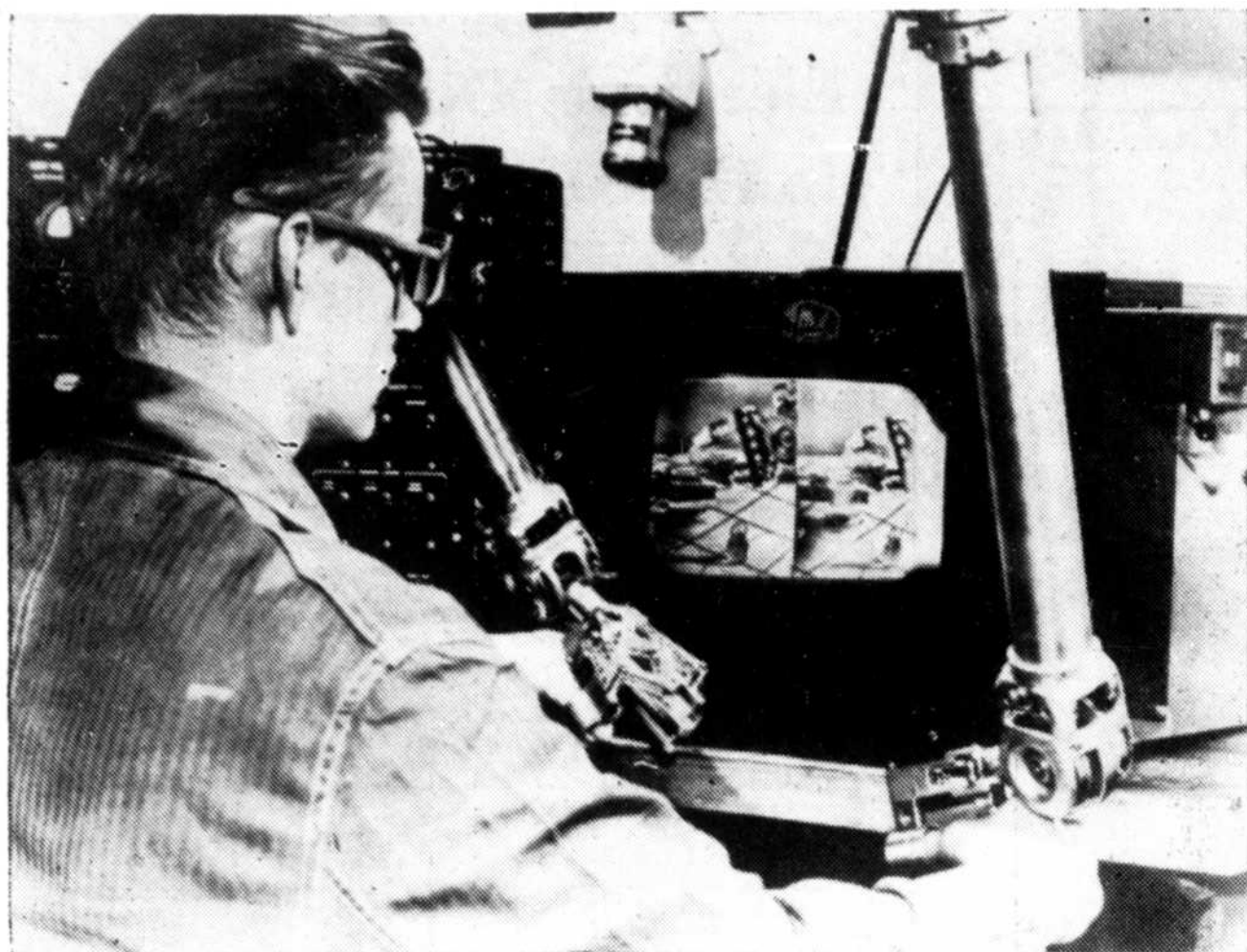
Au laboratoire national d'Argonne, la télévision stéréoscopique ou à trois dimensions permet aux techniciens qui doivent employer des substances radioactives de les voir de près sans danger.
