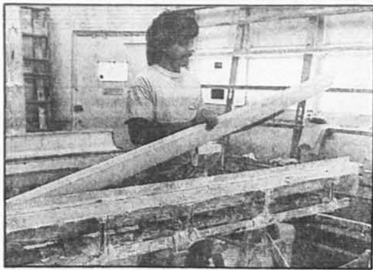
Le démontage d'un segment de moulure.
