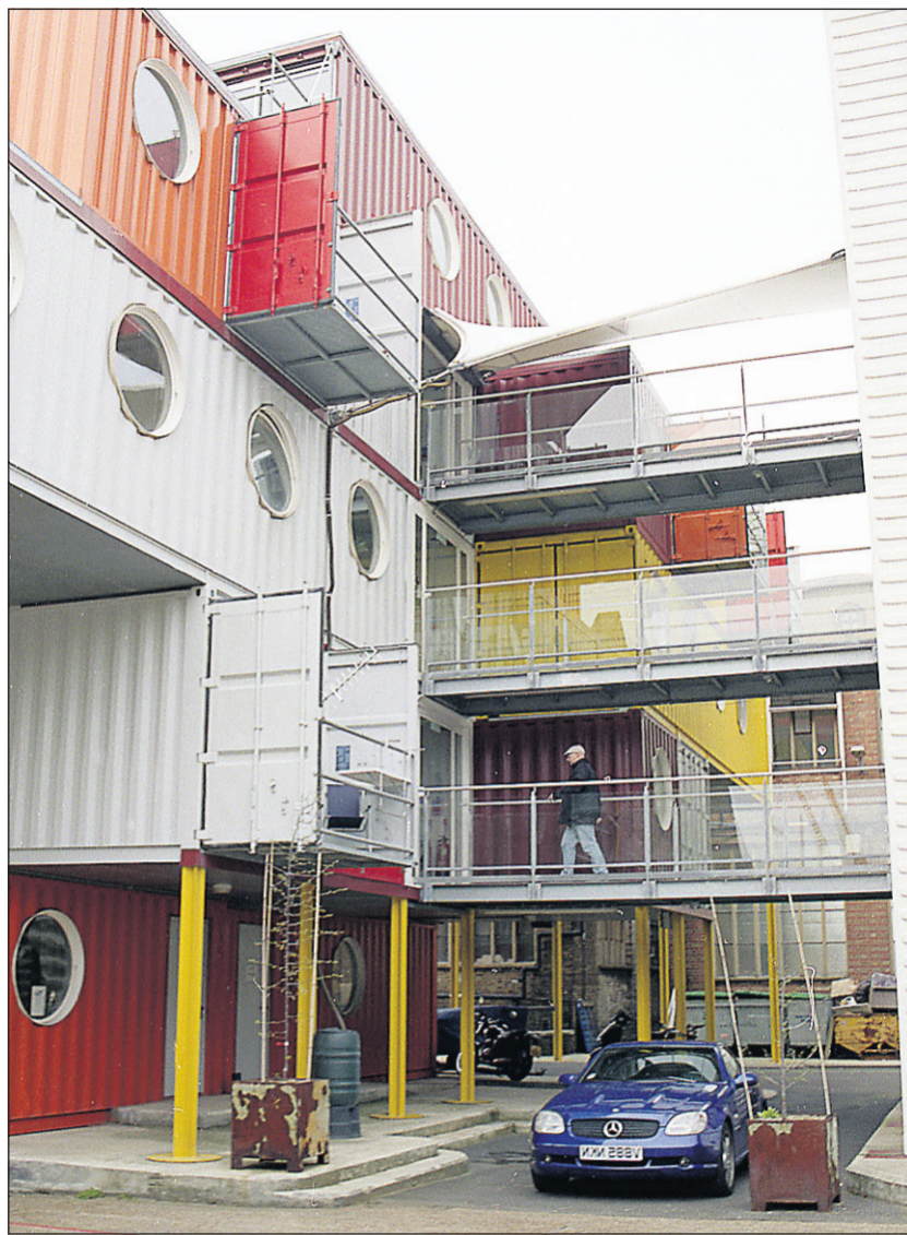
PHOTO ISABELLE AUDET, LA PRESSE © Modulaires, les conteneurs permettent aux promoteurs de créer des immeubles originaux.
